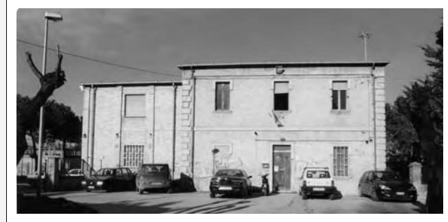
Anni '90 - Ex stazione di Montesilvano spiaggia, con ex fabbricato merci sopraelevato (piazzale esterno). - Collezione ACAF.
