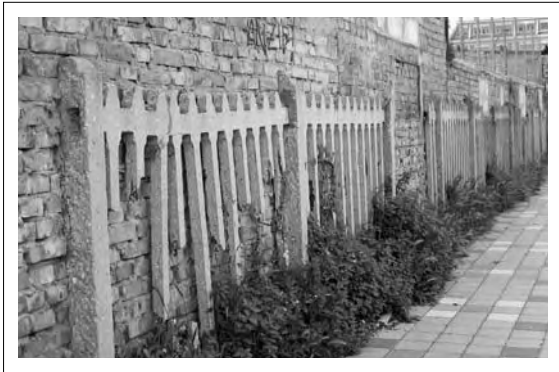
2008 - Resti di staccionata F.E.A.: ex deposito-officina di Pescara-Porto, attuale Via Foscolo. - Collezione Salvatore Di Fazio.
