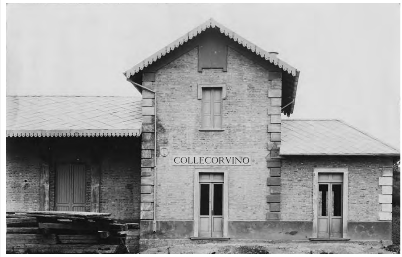
Anni '70 - Fabbricati viaggiatori e merci della stazione di Collecervino (demoliti) - Archivio Comune di Collecervino.
