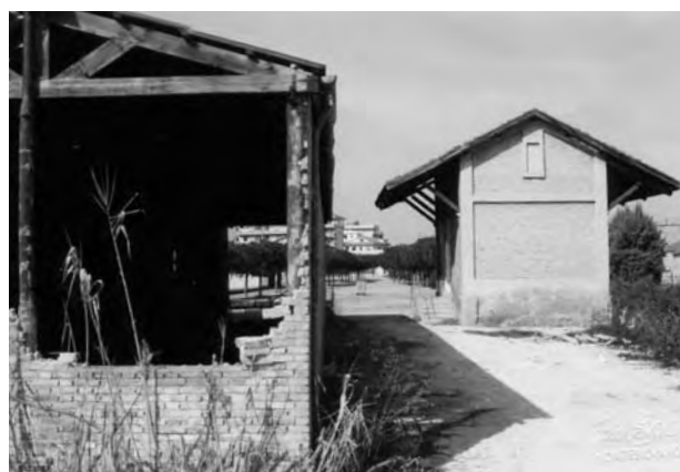
Anni '80 - Ex rimessa e magazzino trasbordo con vista lato sud (demoliti), nella stazione di Montesilvano spiaggia. - Collezione Davide Cavuti.
