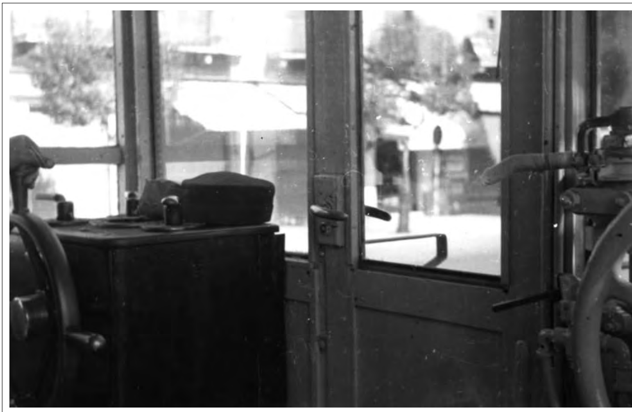
Maggio '62 - Interno della cabina di guida di un'elettromotrice in sosta a Pescara - Foto Renzo Marini.
