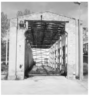
2008 - Particolare dei resti della ex rimessa della stazione capolinea di Penne. - Collezione Salvatore Di Fazio.
