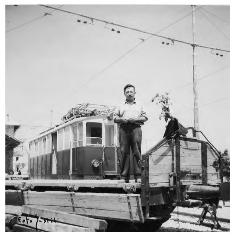
Aprile 1949 - Il personale F.E.A. festeggia la fine dei lavori per il ripristino del servizio ferroviario, nella tratta Pescara-Loreto Aprutino. Il Caposquadra F.E.A. Franco Chiavaroli, in posa su un carro a sponde basse (si notino i fiori esposti sulla maniglia del freno a mano). - Foto Sestili.
