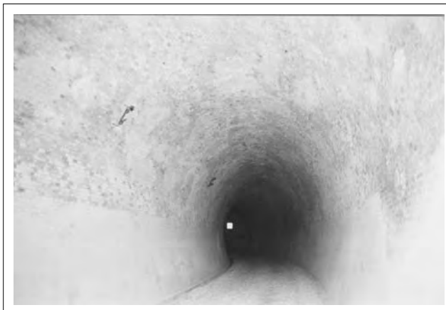
Anni '70 - Interno galleria "Collatuccio". - Collezione Achille Rasetta.
