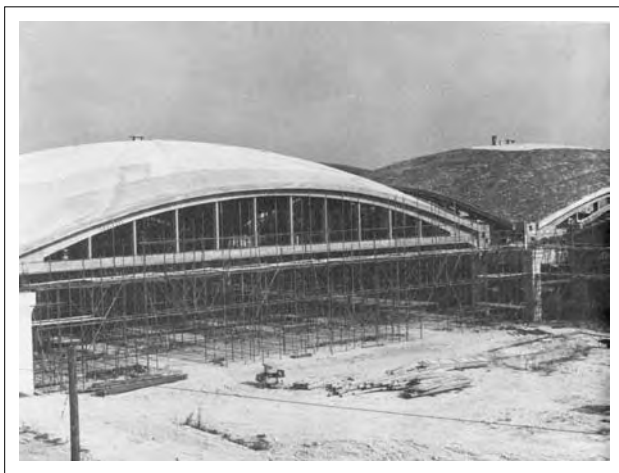
Anni '80 - Cantieri per la costruzione delle nuove infrastrutture aziendali. Collezione Tullio Tonelli.
