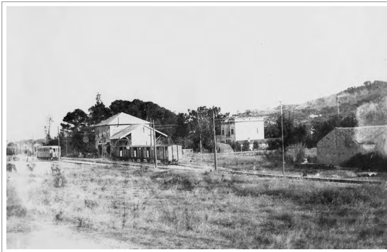
Piazzale interno della Stazione F.E.A. di Montesilvano spiaggia (si notino i quattro carri chiusi attestati al magazzino merci, testimonianza di traffico rilevante). - Collezione Dott. Carlo Mastrangelo.
