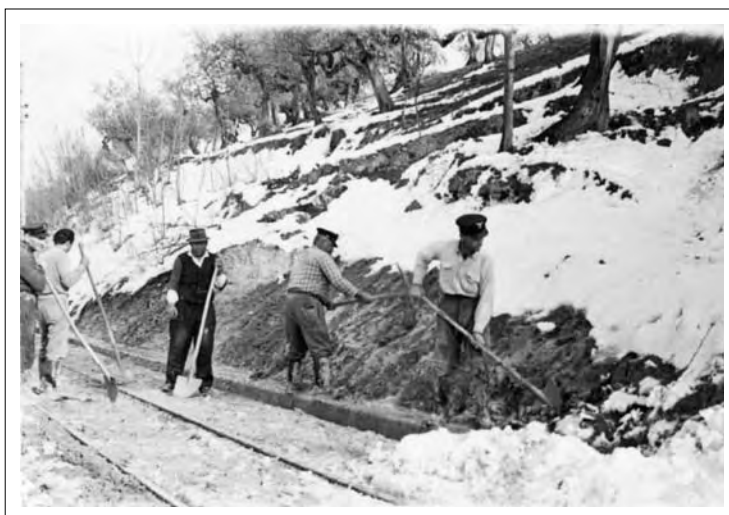
1956 - Operai F.E.A. addetti ai lavori di manutenzione nei pressi di Loreto Aprutino. Da destra: Antonio Pomponio, caposquadra Franco Chiavaroli. - Archivio personale Antonio Pomponio.
