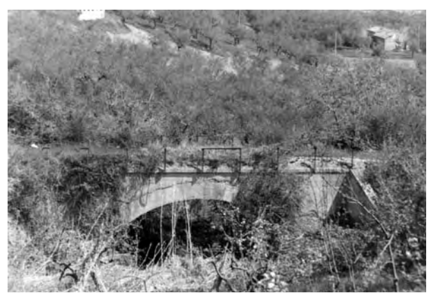
2004 - Ponte ferroviario F.E.A. nei pressi di "Collatuccio" di Loreto Aprutino. - Collezione Ezio Faieta.
