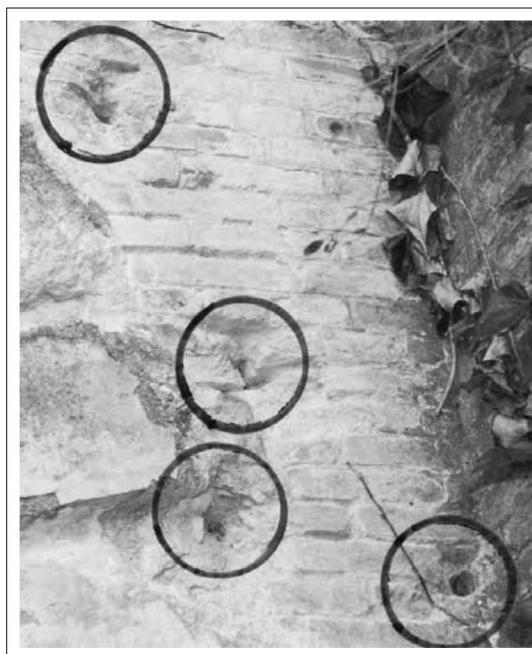
Anni '80 - Particolare dei fori provocati dai colpi esplosi dalle mitragliere aeree (portale della galleria di "Collatuccio"). - Collezione Achille Rasetta.
