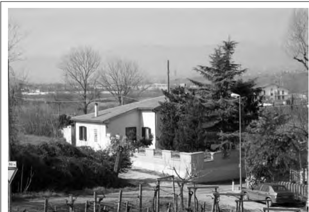
2004 - Ex casa cantoniera "Cappelle-Campotino", ristrutturata ed ampliata (lato binario). - Collezione Salvatore Di Fazio.
