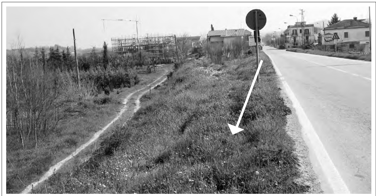
2008 - Sedime ferroviario a lato S.R. 151, in direzione dell'ex stazione F.E.A. di Moscufo, subito dopo l'uscita dal ponte sul fiume "Tavo". - Collezione Salvatore Di Fazio.
