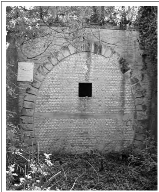
2004 - Galleria "Collatuccio" lato Penne. - Collezione Salvatore Di Fazio.
