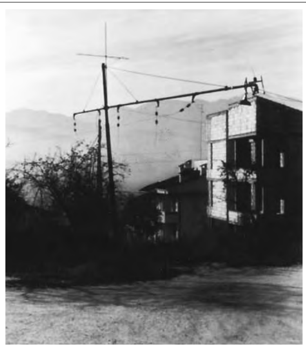
Anni '70 - Resti della palificazione per l'alimentazione elettrica a catenaria nel piazzale della stazione di Penne. - Collezione Achille Rasetta.
