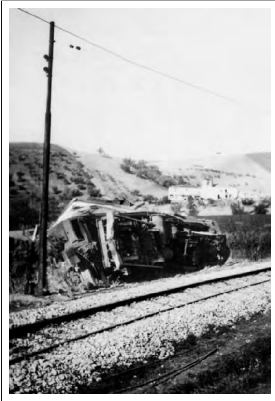
1954 - Locomotore-bagagliaio F.E.A. deragliato in località Collatuccio a Penne. - Archivio personale Achille Rasetta.
