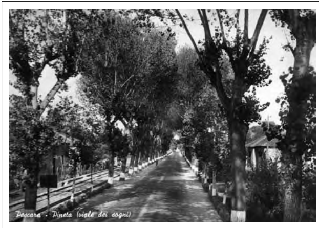
Pescara. A sinistra il tracciato ferroviario urbano della F.E.A.. - Archivio personale ing. Ezio Faieta.
