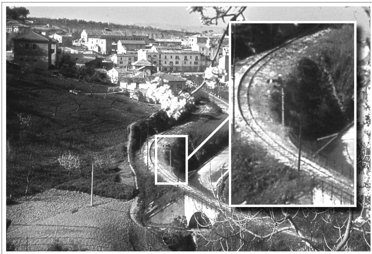
Anni '60 - Tratto di linea F.E.A., quasi dismessa, prima della stazione di Loreto Aprutino (nel riquadro il segnale ad ala semaforica, di protezione della stazione cittadina). - Collezione Achille Rasetta.
