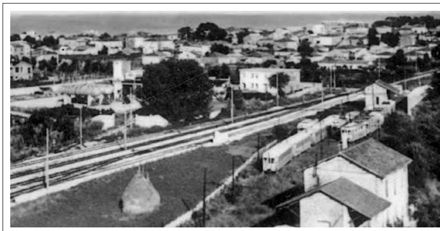
Fine anni '60 - Montesilvano. Impianti FS e F.E.A., una volta collegati. Sulla destra si notano i numerosi mezzi, ormai accantonati, nei depositi F.E.A., e la vegetazione spontanea che comincia a ricoprire i binari del "trenino" dismesso. - Collezione Renzo Gallerati.
