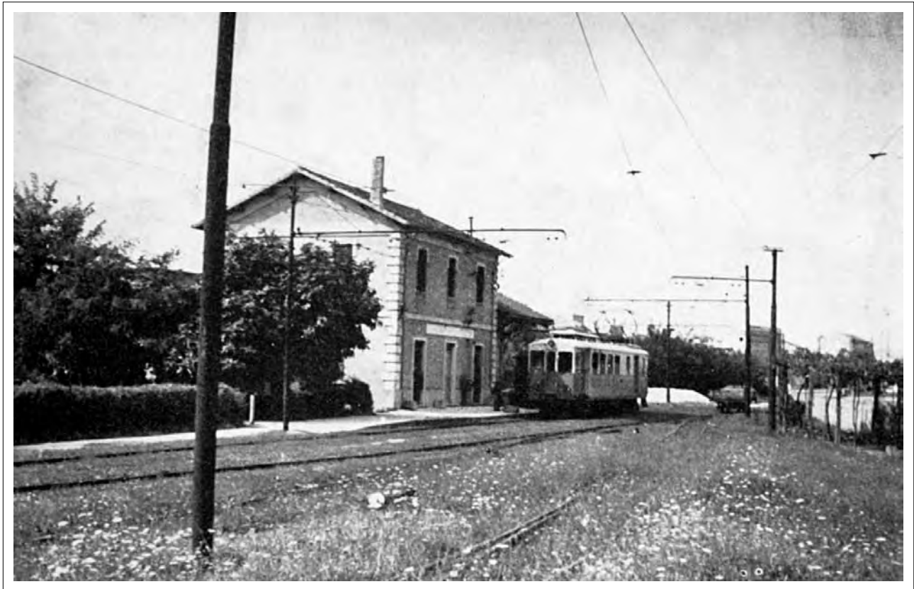
Stazione di Montesilvano spiaggia, con elettromotrice F.E.A. in partenza per Pescara, in un piazzale pressochè ricoperto da vegetazione. - Foto Renzo Marini.
