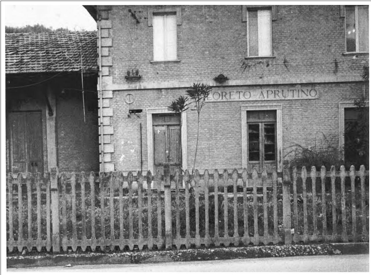
Anni '70 - Fabbricati della stazione di Loreto Aprutino, prima della ristrutturazione. - Collezione Achille Rasetta.
