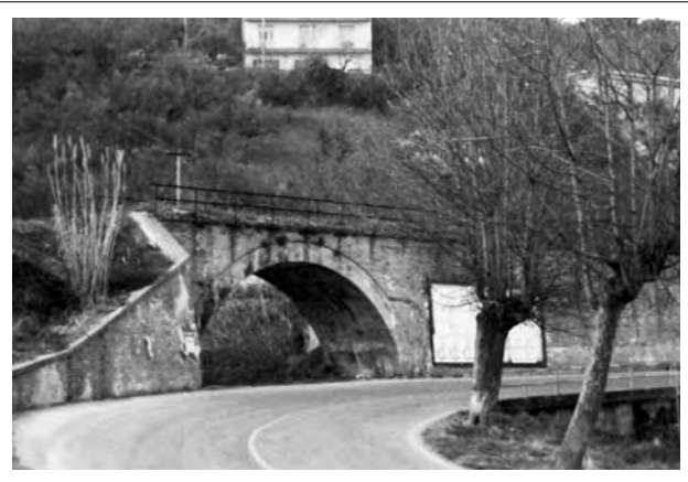
2004 - Ponte ferroviario F.E.A. nei pressi di Loreto Aprutino - Collezione Ezio Faieta.
