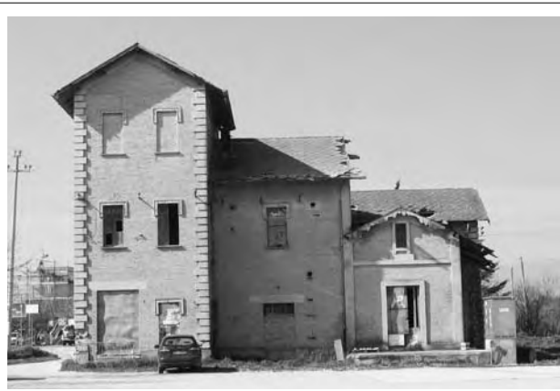
2004 - Fabbricati dell'ex stazione di Moscufo, prima della ristrutturazione (lato est). - Collezione Salvatore Di Fazio.
