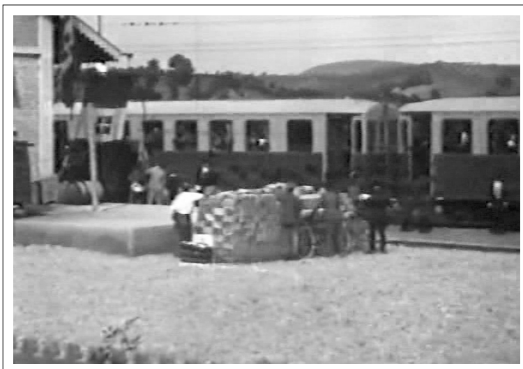
1929 - Nel giorno dell'inaugurazione, fervono i preparativi presso il piano caricatore del magazzino merci di Moscufo. - Collezione ACAF.
