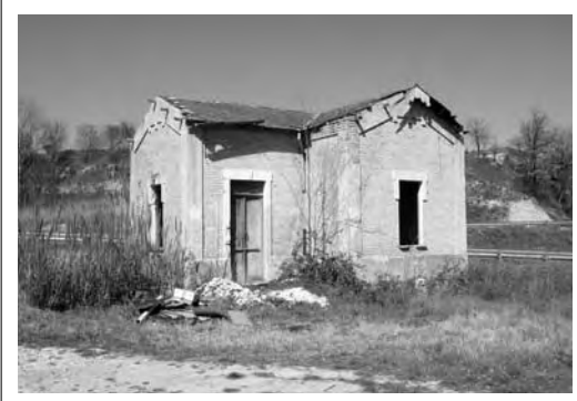
2004 - Ex casa cantoniera "Palladini" di Loreto Aprutino (lato binario). - Collezione Salvatore Di Fazio.
