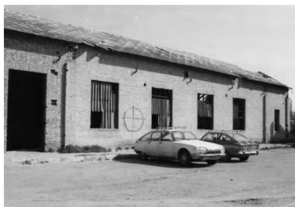
Anni '80 - Ex deposito-officina (demolita), nella stazione di Montesilvano spiaggia. - Collezione Davide Cavuti.
